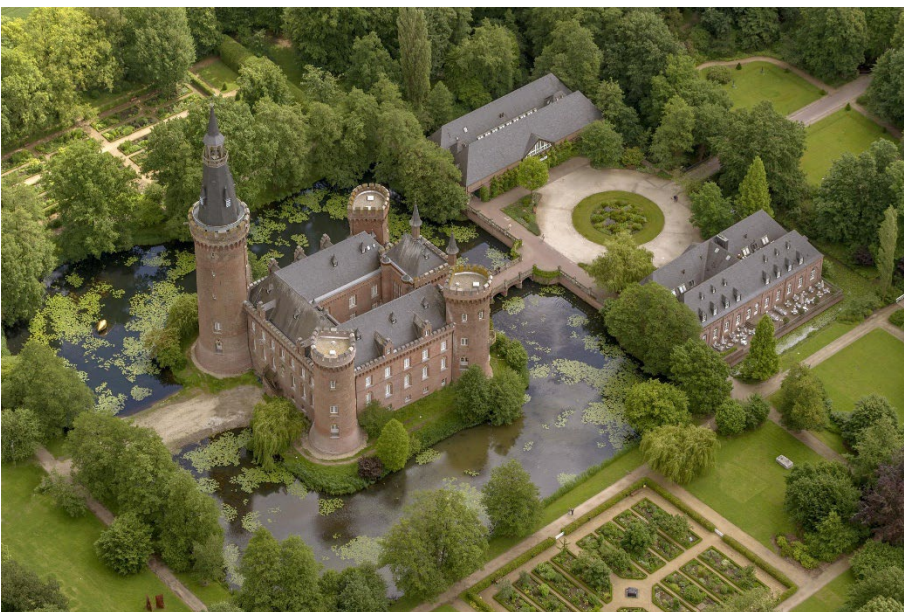
Gesamtanlage, Foto: Hans Blossey
